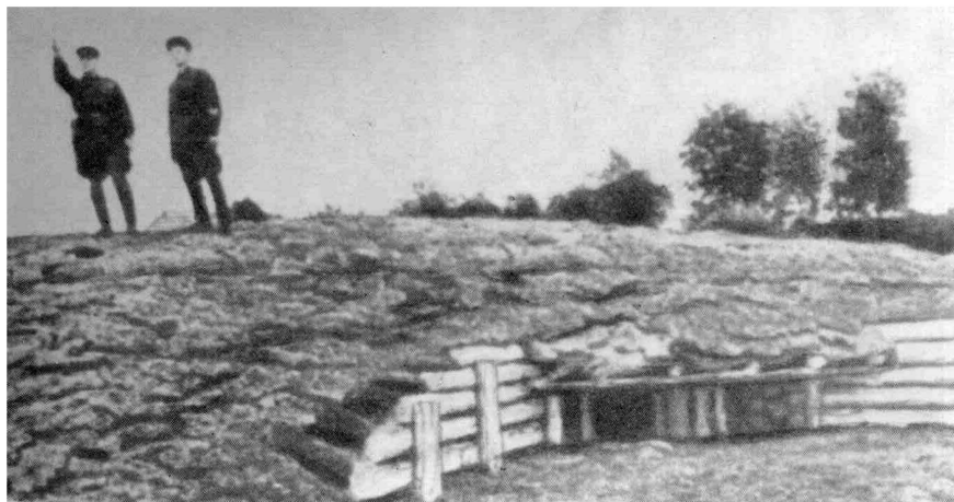
1941 год. Можайская линия обороны. Дзот для 45 мм пушки.
