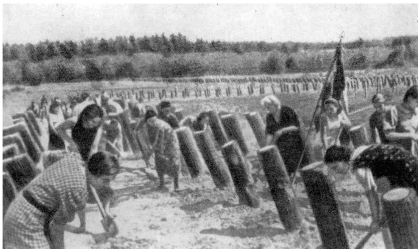
Противотанковые надолбы и «ежи» на ближайших подступах к Москве.
