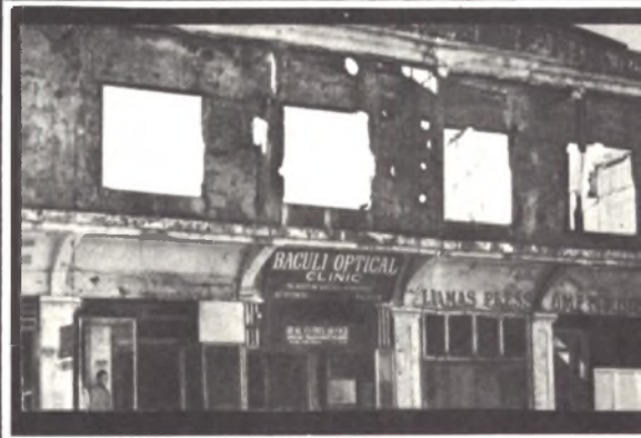
Разрушенное здание в Багио (Филиппины)
