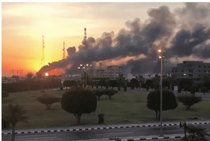
Рис. 3.13. Результаты атаки БПЛА нефтеперерабатывающего завода в г. Абкейк 14 сентября 2019 г., защищаемого ЗРК Patriot PAC-3
