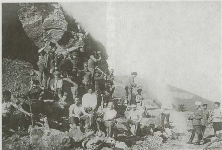
На подрывных работах Кубанского офицерского дивизиона
