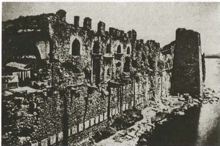
Стены Царьграда. Современный вид.
