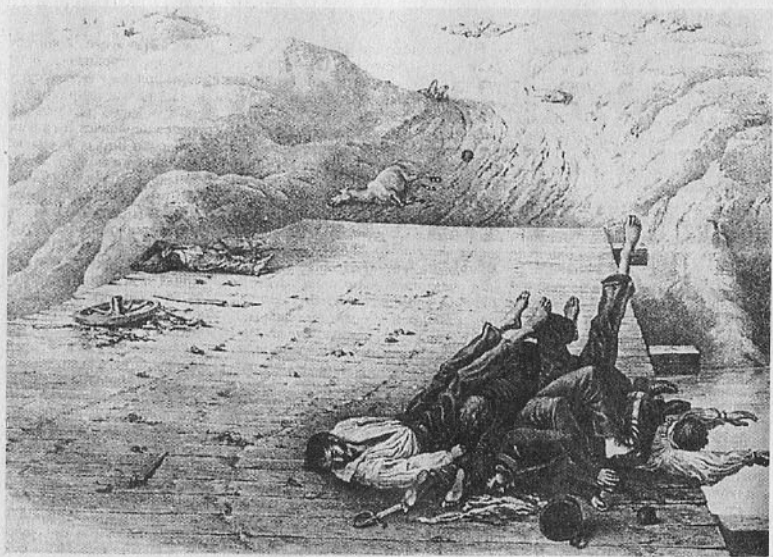
Мост через реку Колоча у села Бородино
