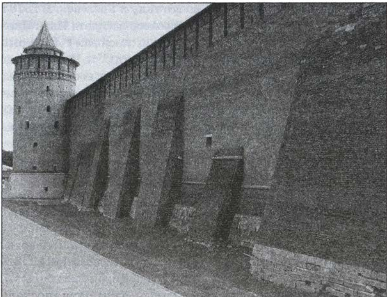
Стена коломенского кремля. Современная фотография
