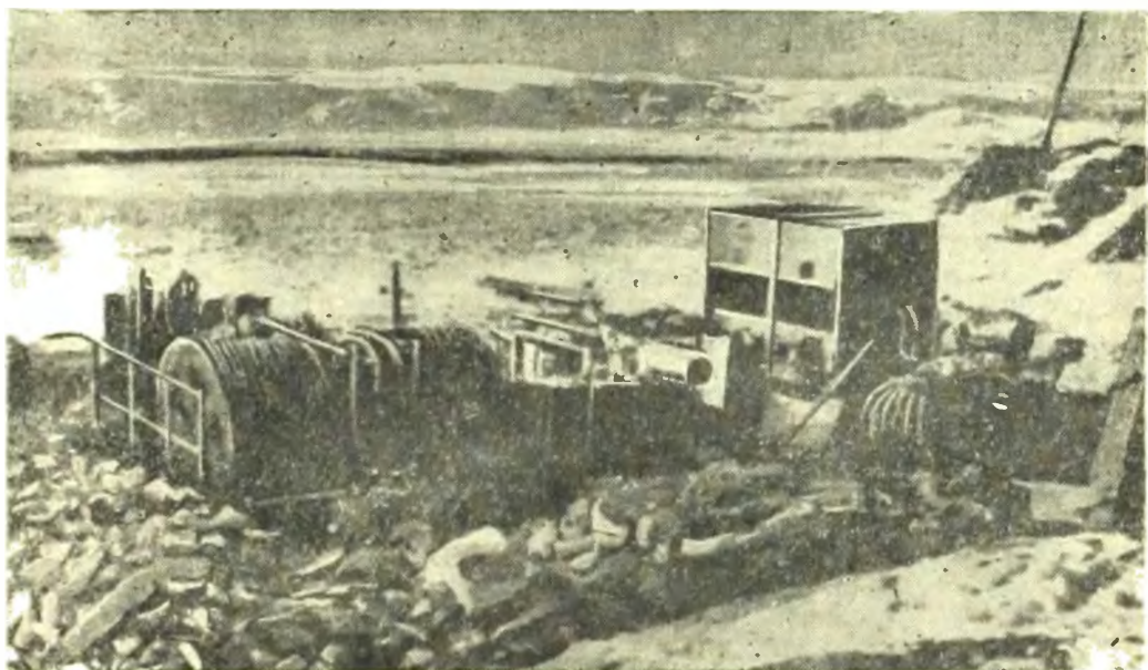
Одна из разрушенных гитлеровцами шахт в Кривбассе.
