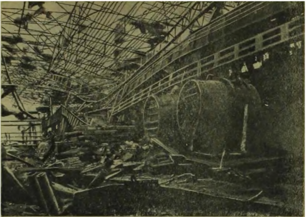
Мартеновский цех № 5—8 завода имени Петровского, разрушенный фашистскими захватчиками.
