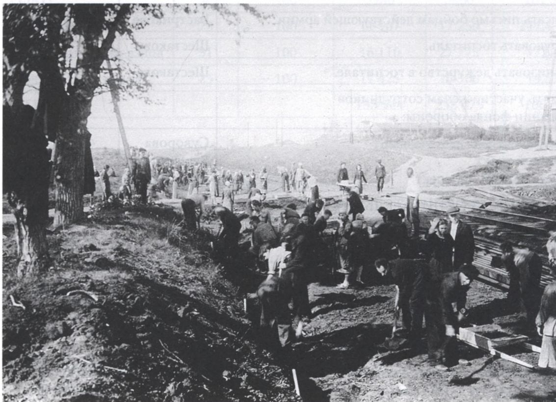
Работники Молотовского завода № 19 им. И. В. Сталина на работах по строительству железнодорожной ветки. 1942 г.
