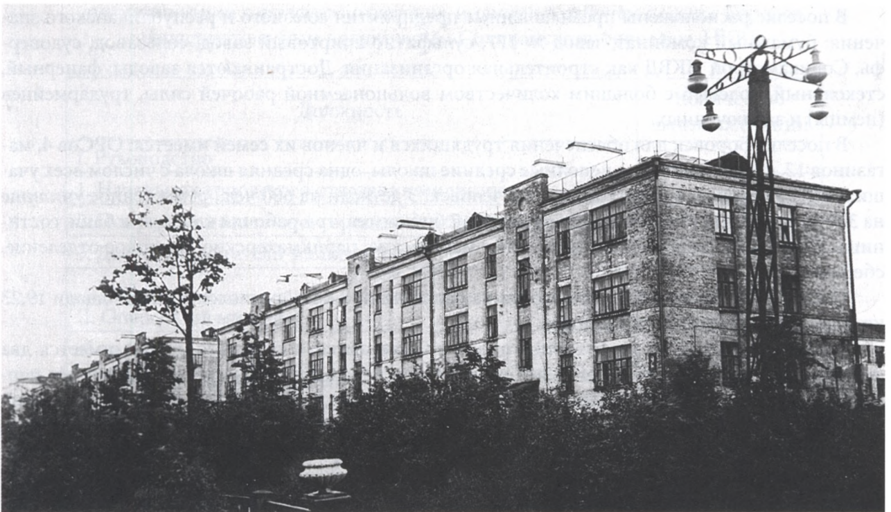
Жилое здание в Молотовском районе г. Молотова. 1943 г. ПермГАСПИ. Ф. 90. Оп. 2Д. Д. 320. Л. 5.
