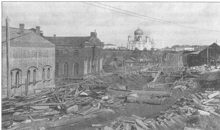
Строительство снарядо-механического цеха на Александровском снарядоделательном заводе. г. Петрозаводск, 1916 г.
