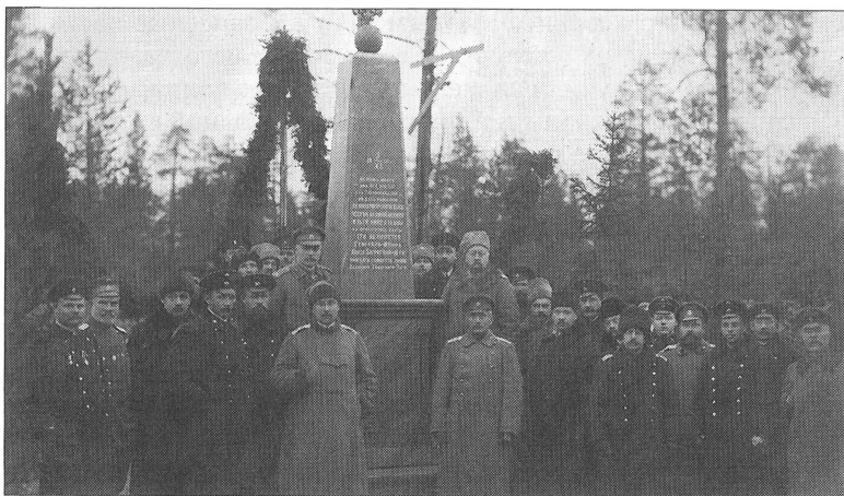
У знака соединения северного и центрального участков Мурманской железной дороги. Пикет № 618 на 537 версте дороги, 3 ноября 1916 г.
