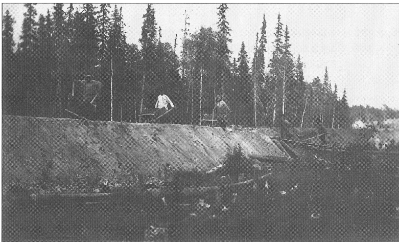
Строительство Мурманской железной дороги. Тачечные земляные работы. 1916 г.
