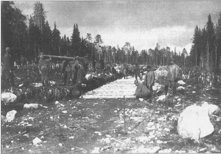
Укладка шпал на строительстве Мурманской железной дороги. 1916 г.
