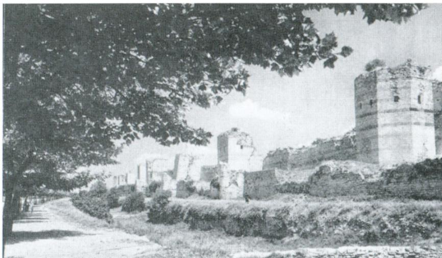
Фрагмент тройной стены, прикрывающей Город с суши. Виден прежде всего ряд внутренних башен, затем — менее высокие внешние башни, разрушенные при обстреле из пушек. В центре — ров, доставивший османам столько неприятностей в ходе осады; теперь он по большей части засыпан, но некогда был выложен кирпичами и имел 10 футов в глубину. Предполагалось, что если атакующие пересекут его, то окажутся на открытой террасе под сильным огнём, прежде чем смогут атаковать внешнюю стену.
