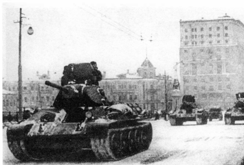
В праздничном параде приняли участие и танковые бригады. Танк КВ-1 с 76-мм орудием и типичными для немецких конструкций хорошо развитыми опорными катками (фото вверху ). Колонна танков Т-34 следует по Москве (фото внизу )
