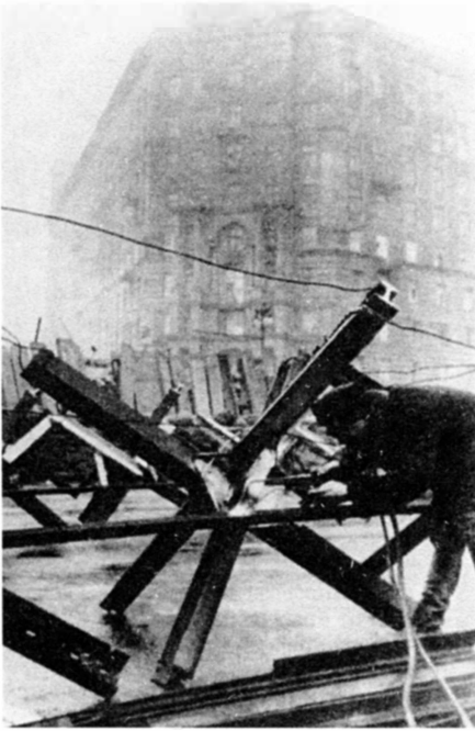
Уличное заграждение на Волоколамском шоссе — на западной окраине города. Бойцы инженерных войск сварили железнодорожные рельсы, превратив их в непреодолимые для танков препятствия
