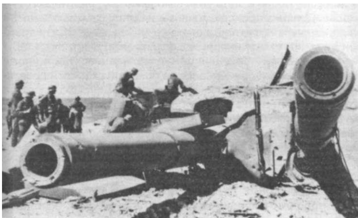
Немецкие солдаты обследуют орудия 30-й береговой батареи. Одна из башен батареи якобы была выведена из строя прямым попаданием бомбы, сброшенной с Ju 87.
