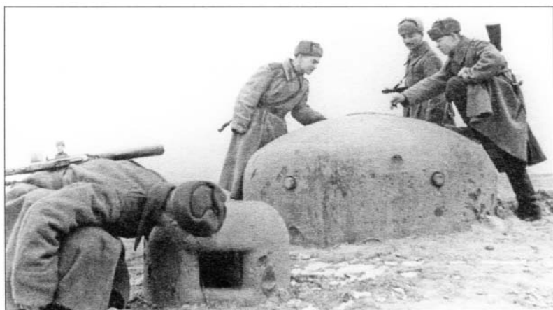
Один из укрепленных районов, взятый нашими войсками. Бойцы рассматривают шестиамбразурный ДОТ, прикрывающий подступы к подземному заводу боеприпасов. На колпаке ДОТа видны вмятины от прямых попаданий 203-мм гаубицы Б-4. 1-й Белорусский фронт, март 1945 года (АВЛ)
