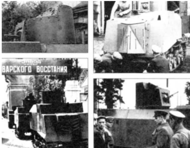
Серия фотографий, посвященных созданию бронированных тракторов на одесских заводах. В историографии они получили индекс «НИ» («На испуг»). Первые два образца танка трактора были изготовлены на базе транспортных тракторов СТ.3-5 к 20 августа 1941 года. Они и изображены на фотографиях. Всего до 15 октября в Одессе было изготовлено 69 бронетракторов и бронеавтомобилей на различной тракторной и автомобильной базе (АВЛ)
