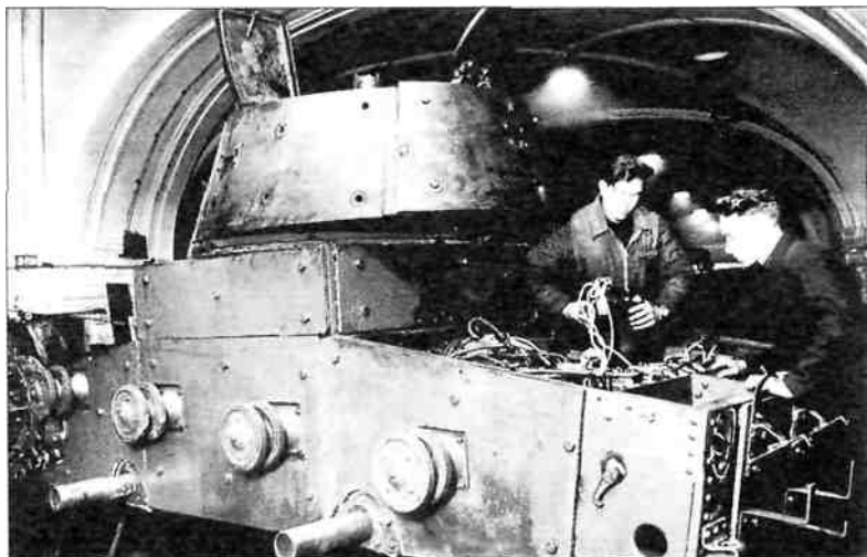
Экипировка танка Т 26 на одном из предприятий Ленинграда. Осень 1941 года. Обратите внимание, что крепления для установки глушителя и буксирного троса приварены к дополнительной броне (РГАКФД)
