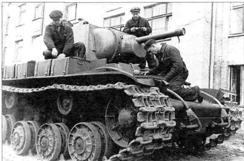
Подготовка рабочими к передаче танка KV-1 представителям Красной армии. На надгусеничных полках установлены дополнительные топливные баки. Ленинград, сентябрь—октябрь 1941 года (АВЛ)
