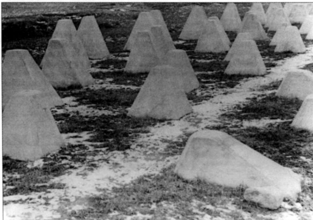
Основной задачей подобных инженерных сооружений являлась их способность остановить советские танки. Снимки сделаны в марте 1945 года.
