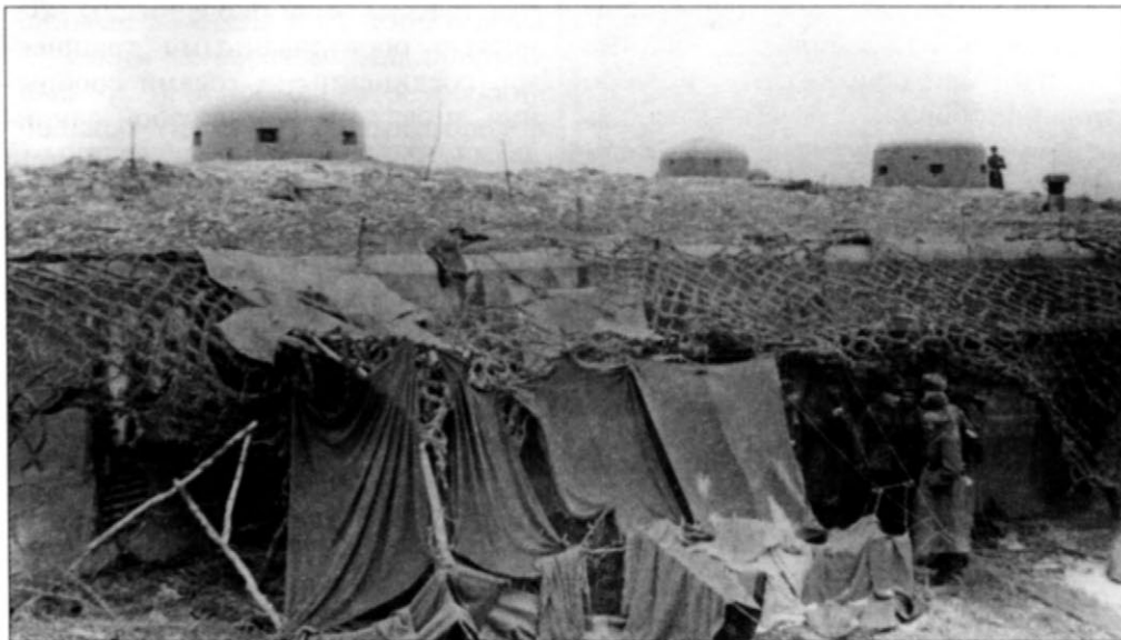
Вход в германскую «подземную крепость». Сложное инженерное сооружение с интересом осматривают наши специалисты. 1-й Белорусский фронт, март 1945 года.
