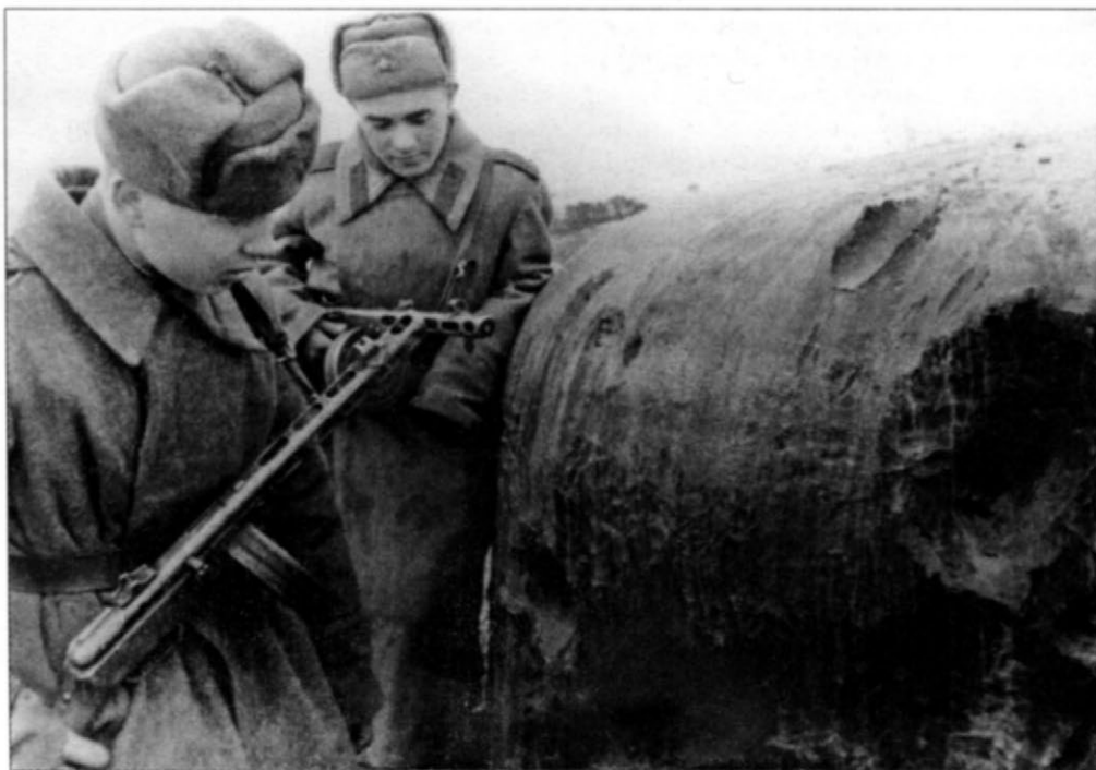
На колпаке ДОТа видны вмятины от прямых попаданий 203-мм гаубицы Б-4. 1-й Белорусский фронт, март 1945 года.
