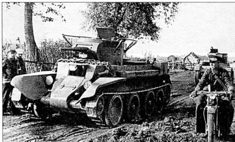
На марше механизированное соединение Красной армии. Роль командирской машины выполняет радиый танк БТ-7 образца 1935 года с поручневой антенной, за ним следуют линейные танки Т-26/33
