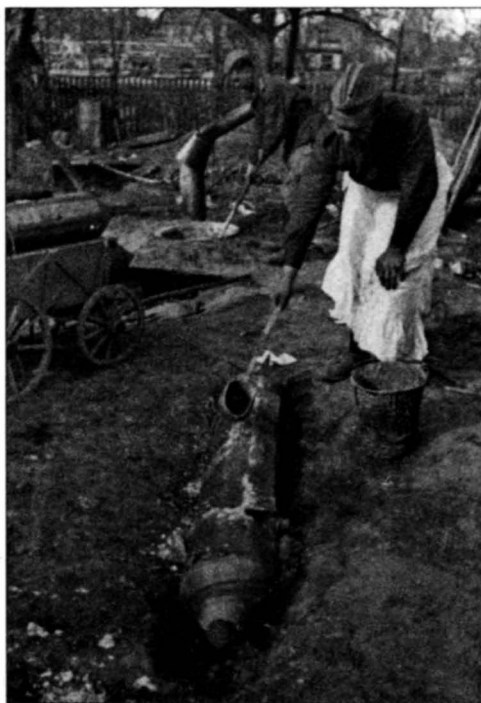
Изготовление «летающей торпеды». Красноармейцы С.С. Бахарев и П.Ф. Афанасьев собирают внешний корпус изделия, а сапер Е.Ф. Наумов заливает корпус «торпеды» толлом. 62-я инженерно-саперная бригада, конец апреля 1945 года.
