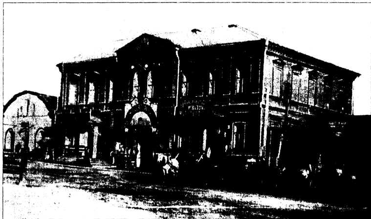
г. Воткинск. Здание волостного правления.
