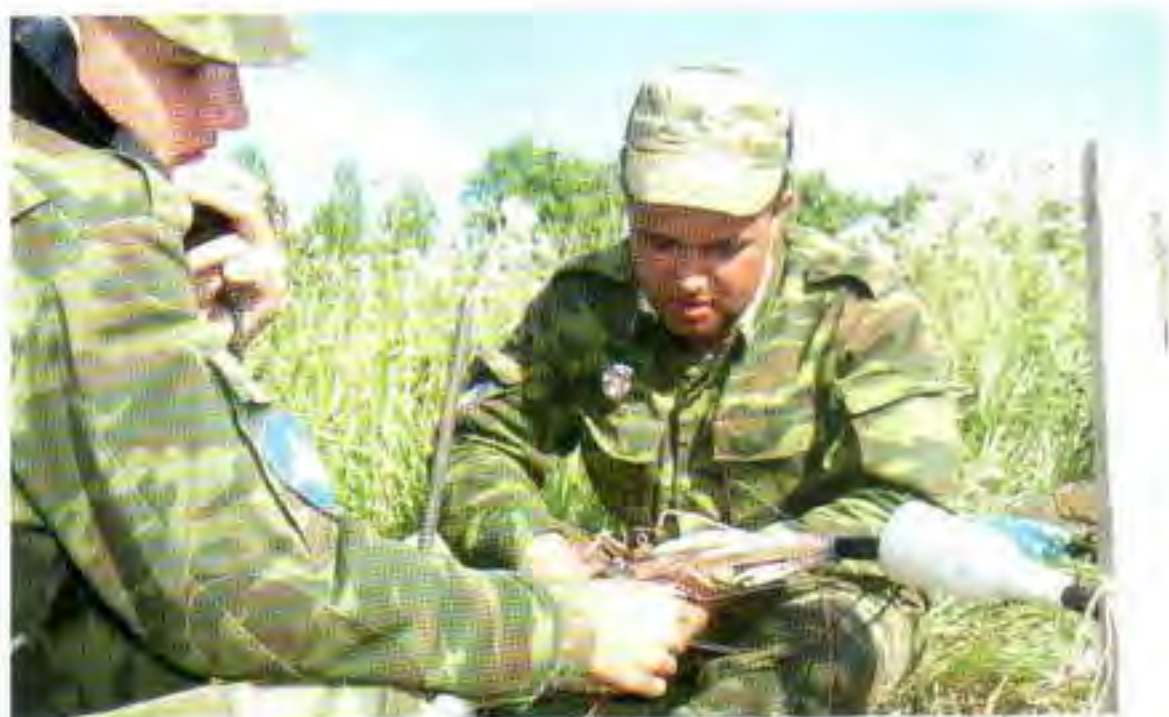
Аварийно-восстановительный расчет телефонного центра за устранением неисправности
