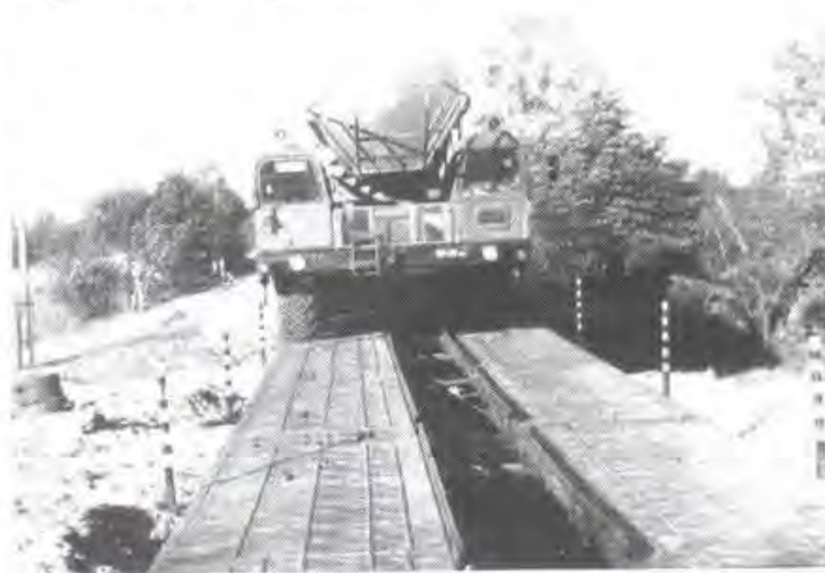
Преодоление узких преград по мостовому переходу с использованием комплекта ТММ. 1992 год
