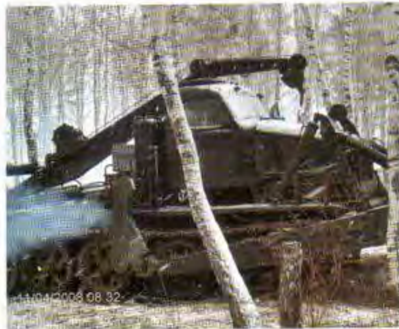
Тяжелая техника батальона прокладывает дорогу в полевом районе. 2008 год
