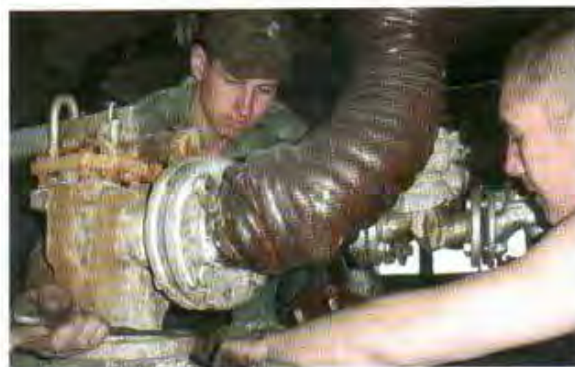
Ремонт оборудования котельной
