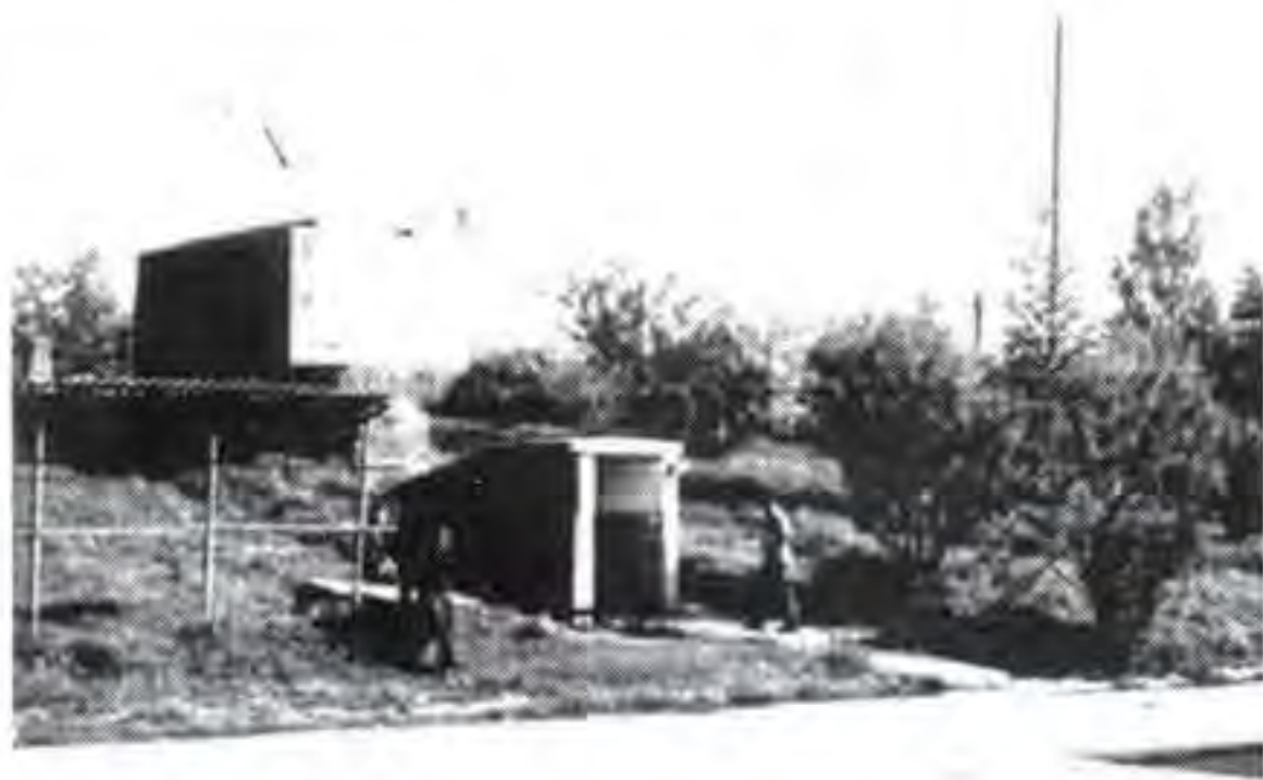
Центральный вход в сооружение командного пункта комплекса 8П764Н
