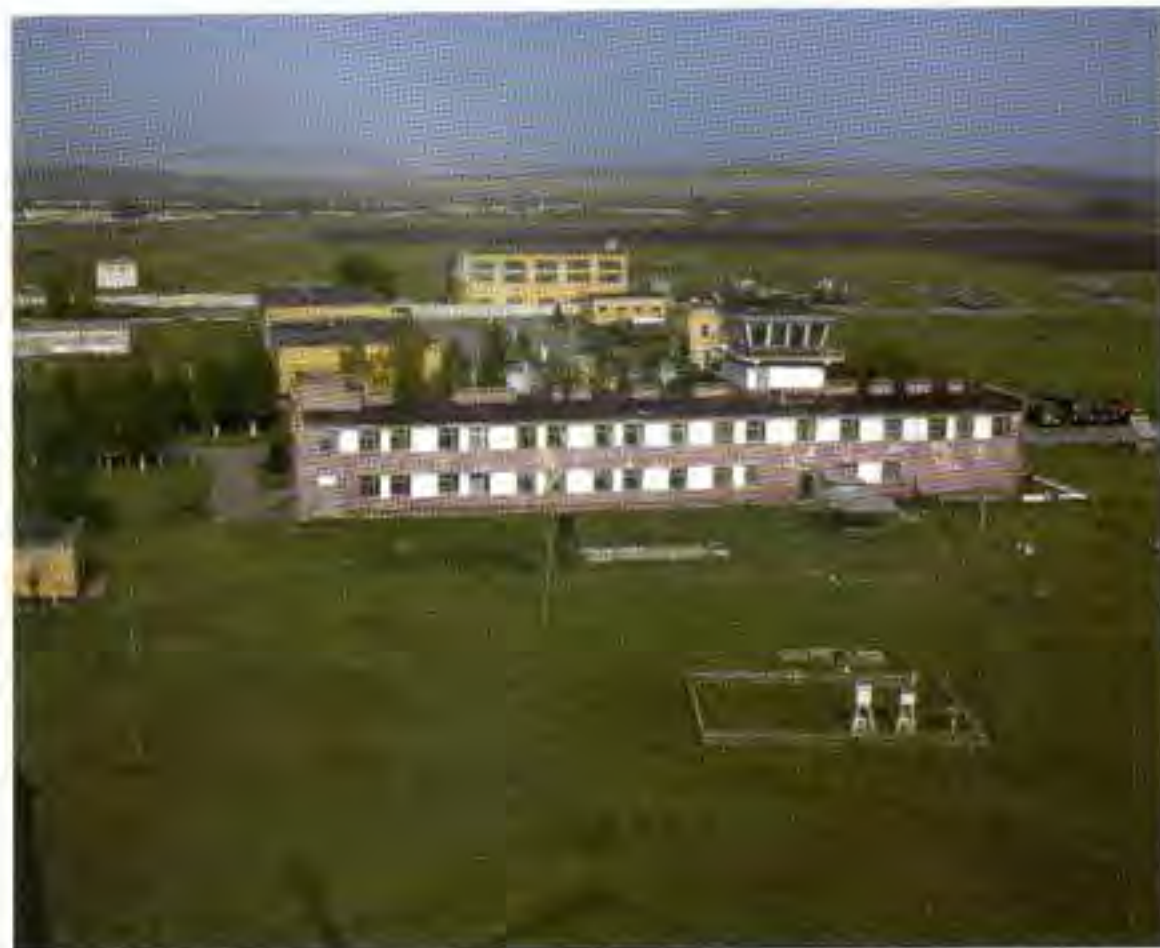
Комплексное здание Отдельной вертолетной эскадрильи. Город Ужур
