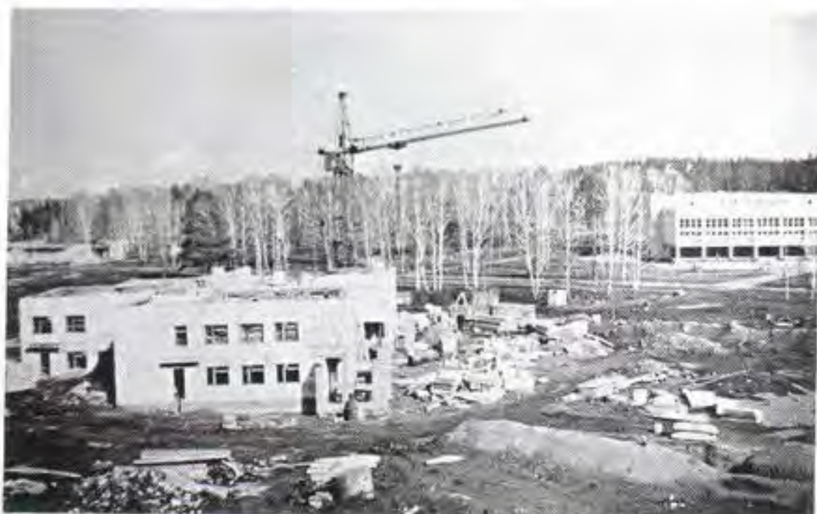
Строительство детского сада Ромашка. 1984 год
