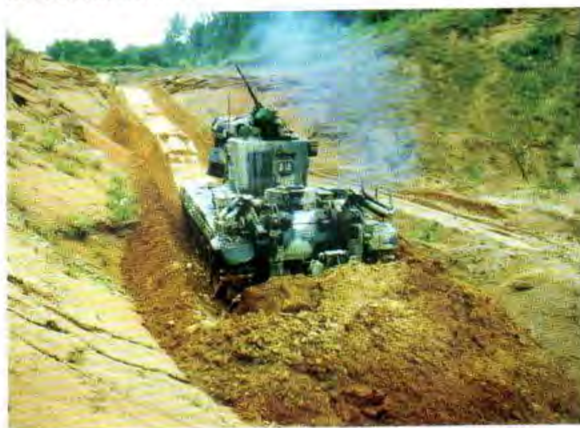
Оборудование колонного пути с использованием ИМП-2
