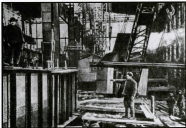
На стройке мартеновского цеха Челябинского металлургического завода
