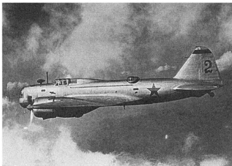
Дальний бомбардировщик ДБ-3Б в полете. Перед кабиной пилота установлен радиополукомпас РПК-2 (рамочная антенна в обтекателе)
