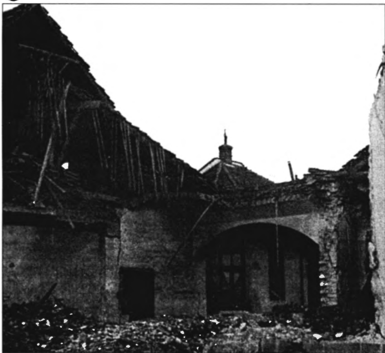
Дома в Кошице, разрушенные во время «советского нападения»
