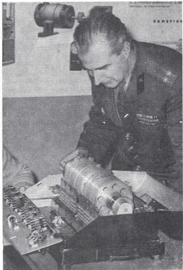
Рис. 35. Автор данного пособия за подготовкой имитатора звукометрических сигналов для станции СЧЗМ-36 (1976 г.)
