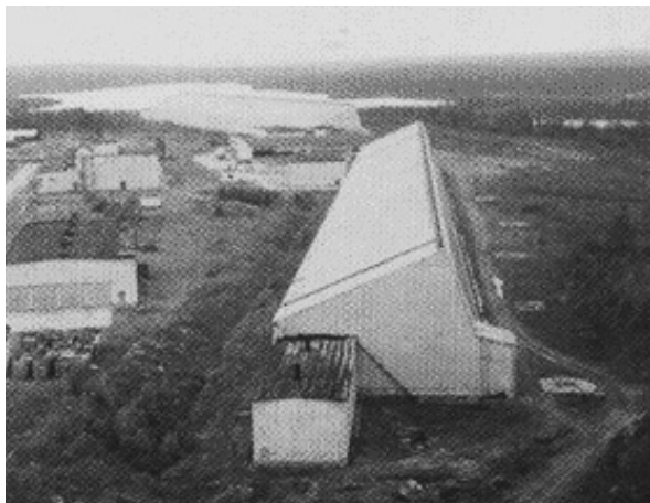
Рис. 3.10. Радиолокационная станция СПРН «Днепр»
