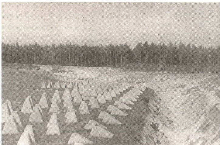
Бетонные укрепления на Зееловских высотах
