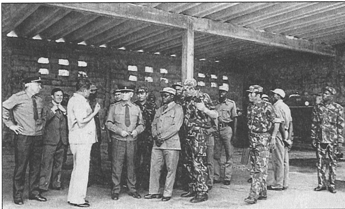
Маршал Л. С. Соколов осматривает построенные хранилища для танков.
