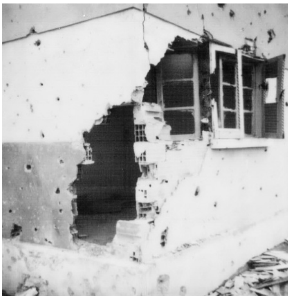
Дом повреждённый артобстрелом в Куито-Кунавале
