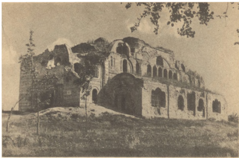
Развалины здания бывшей церкви, в котором до войны находился клуб 84-го стрелкового полка.
