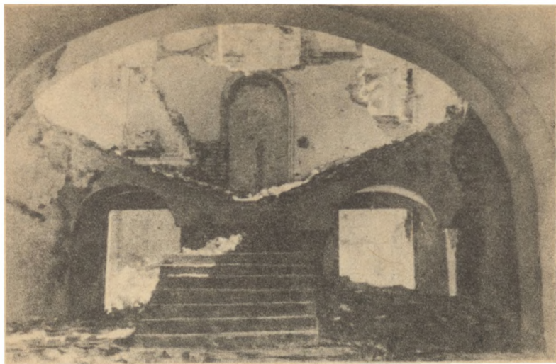
Развалины здания Инженерного управления.
