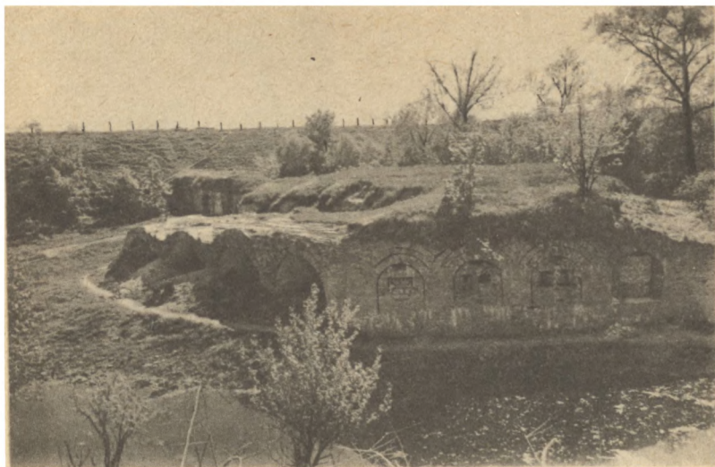
Восточная часть главного вала.
