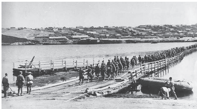
К началу контрнаступления под Сталинградом батальон Ивана Михайловича уже мог возводить надежные мосты
