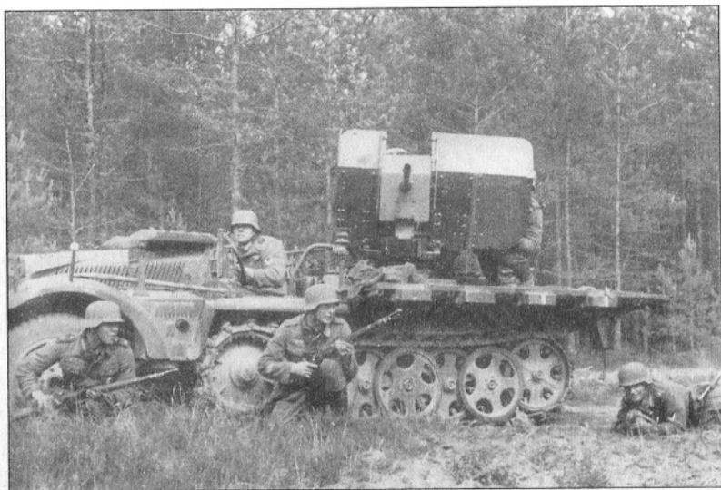
2-см зенитный автомат Flak.30 на полугусеничном тягаче Sd.Kfz. 10/4. Полукустарная, но очень эффективная установка при стрельбе как по воздушным, так и по наземным целям. Поражала броню танков Т-26, БТ, Т-37
