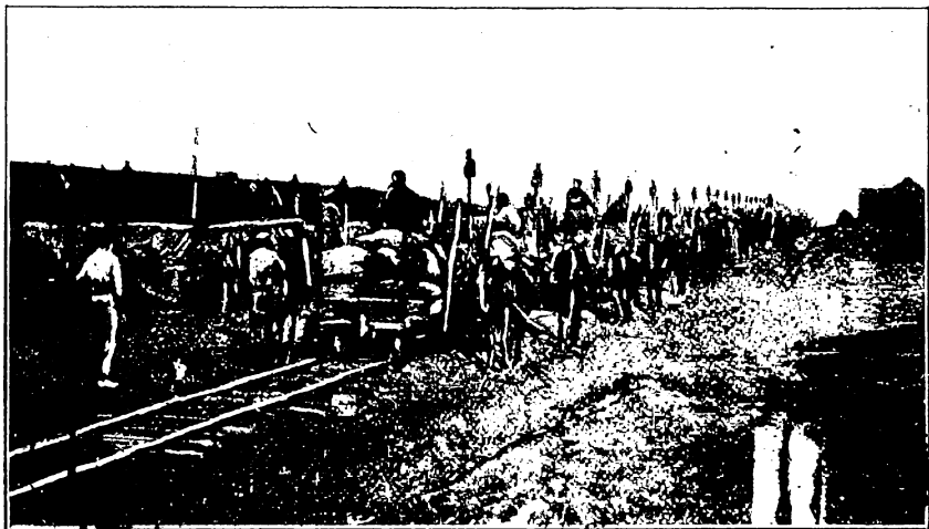
Рис. 8. Готовый к отправлению поезд конной полевой ж. д. Ст. Малиновка Малиновской пол. конной ж. д.
