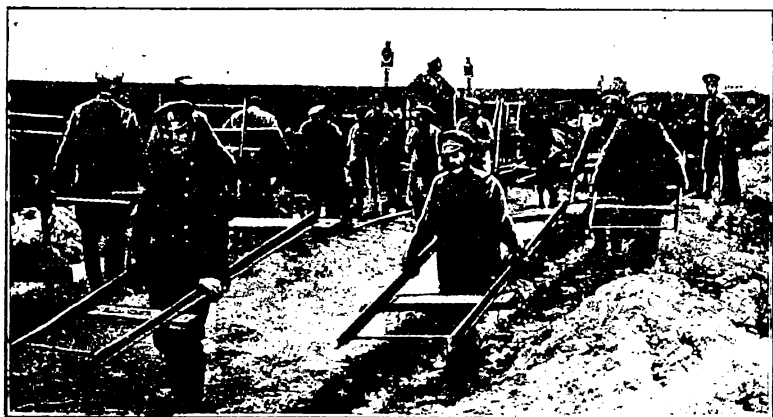
Рис. 7. Укладка полевой конной ж. д.
