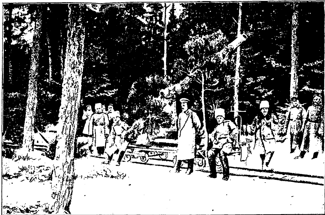
Рис. 25. Установка тяжелой артиллерии на позиции под Летценом при помощи полевой конной жел. дор.
