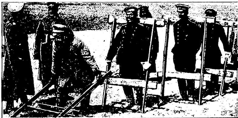
Рис. 6. Нормальное 1,5 м звено полевой конной ж. д. весом 30 кг.
