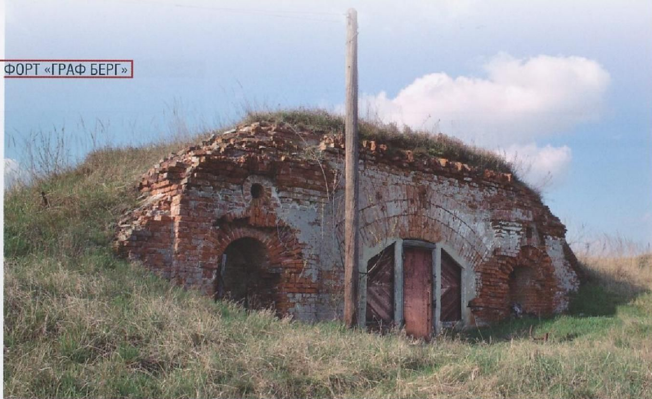
Кирпичный казематированный траверс спустя 140 лет после постройки. В центре убежище для солдат, по бокам – шахты для подъема боеприпасов
