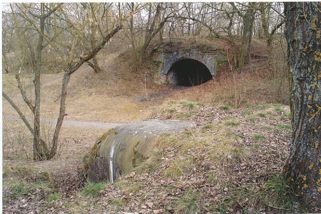
Фрагменты форта IV. На переднем плане видна часть бетонной потерны. За ней – кирпичный каземат в земляном валу
