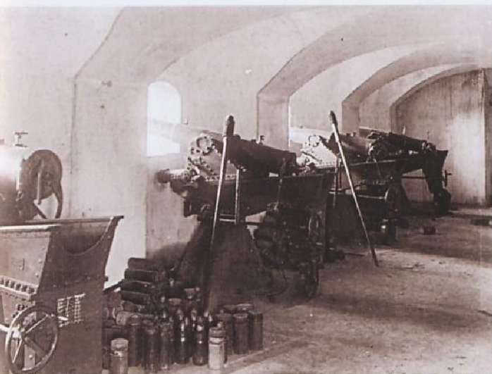
Трехдюймовые пушки на лафете Дурляхера в капонирае
