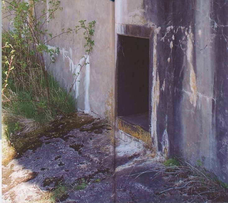
Артиллерийская амбразура переднего капонира форта V. Орудие, находившееся внутри, простреливало сектор вдоль обводного канала
