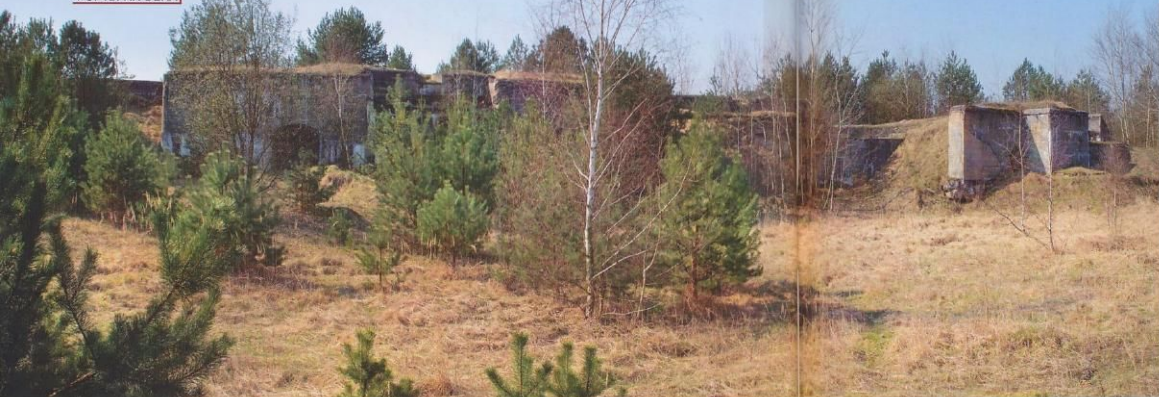
Разрушенное убежище для гарнизона форта литеры «Л»
