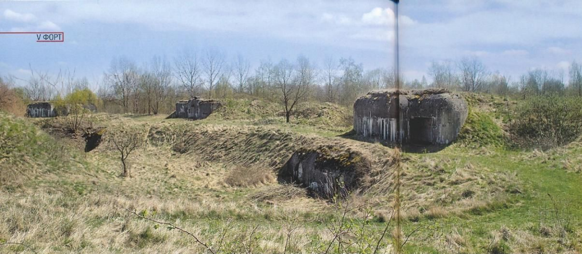
Внешний вал форта V с казематированными траверсами. Пушки в мирное время находились внутри укрытий, а в случае боевых действий устанавливались на огневых позициях вдоль вала
