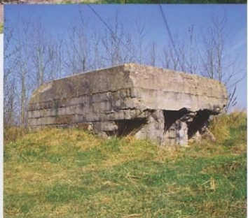
Фрагмент озорного пункта «Г-П» — позиция для наблюдателя. Сверху бетонной постройки находился бронеколпак
