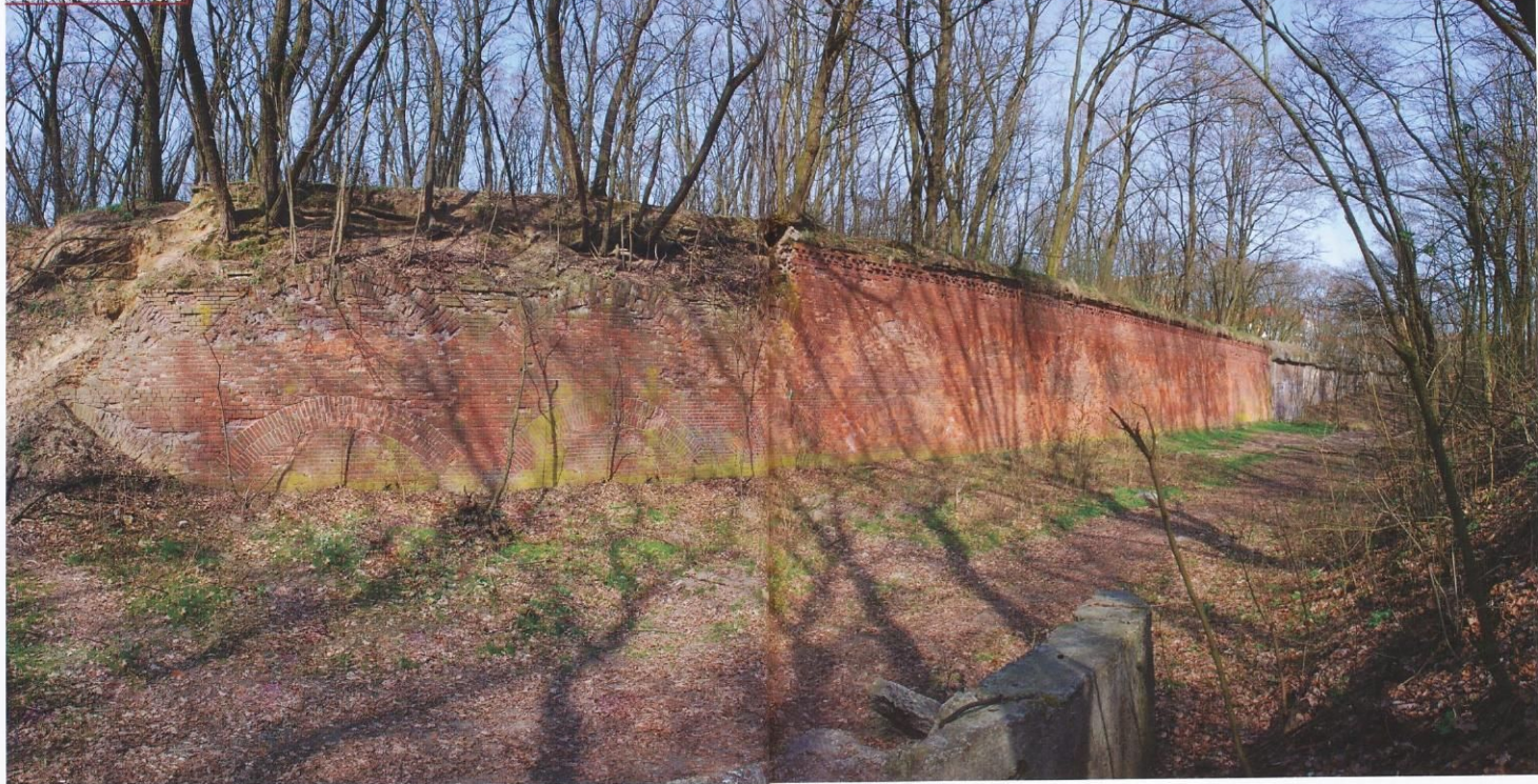
Контрэскарпная стена и сухой ров форта XVIII-Б. Великолепное качество кирпичной кладки вызывает восхищение даже через 140 лет
