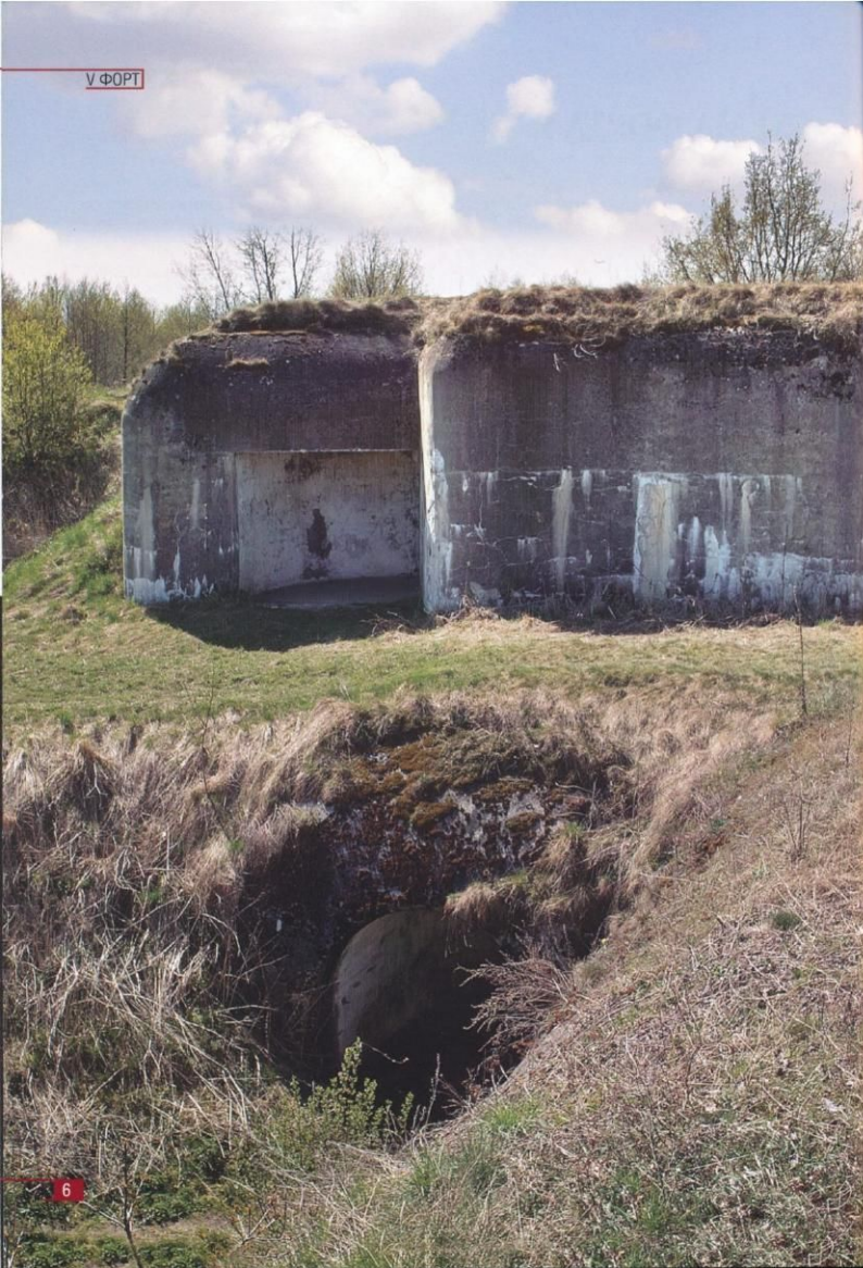
Двухэтажный казематированный траверс в валу форта V с наблюдательным пунктом
