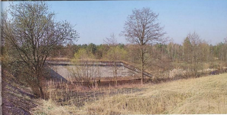
Вид с центральной потерны на передний капонир форта VI. Этот форт, модернизированный в 1908-1909 гг., сохранился практически полностью
