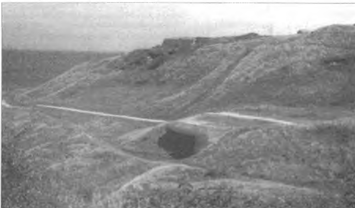
Батарея «Креше III» севернее Булони. Позади «Креше III» находилась «Креше I» с орудиями калибра 194-мм. Севернее на побережье располагалась «Креше II» со 105-мм орудиями. На переднем плане виден бункер 75-мм орудия и бункер управления огнем (справа наверху) с необычной наблюдательной позицией впереди (слева) от него.
