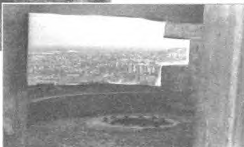
Вид орудийного каземата изнутри, на полу видна точка установки 105-мм орудия.
