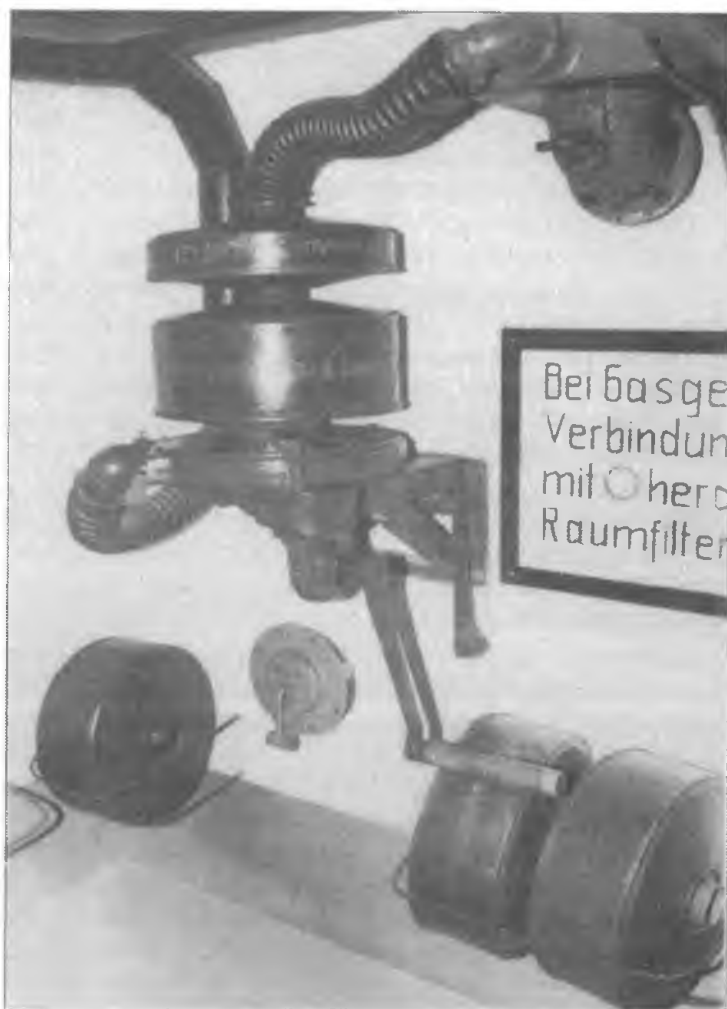
Вентилятор и фильтры в цокольном этаже бункера в Рива-Белла.
