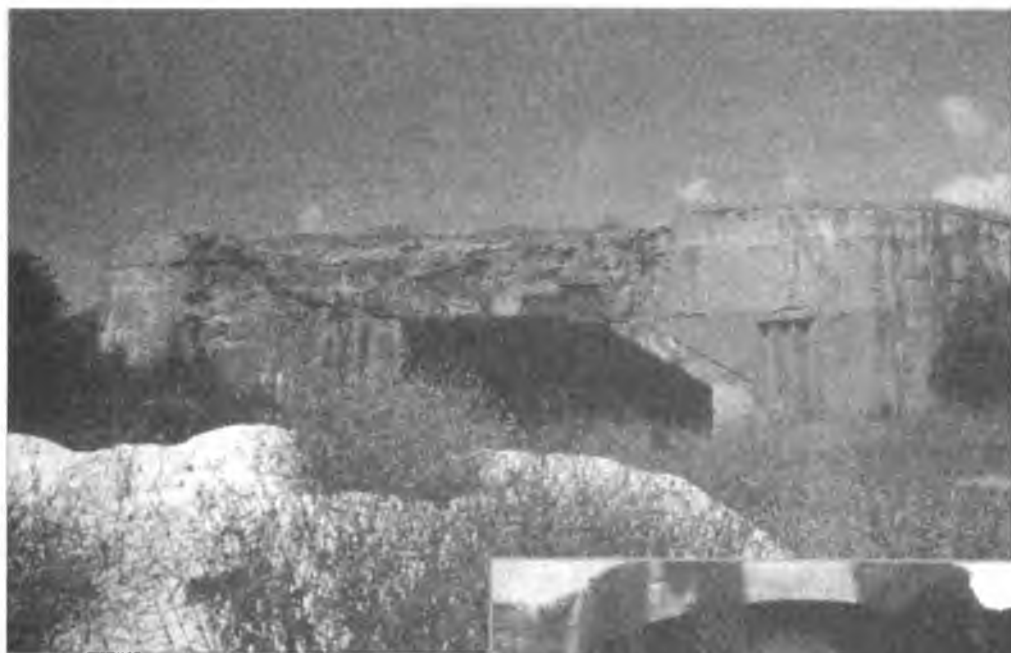
Слева: Развалины каземата батареи «Граф Шпее», расположенной в Керингаре к востоку от Бреста, неподалеку от Ле-Конке в населенном пункте Лохрист.
