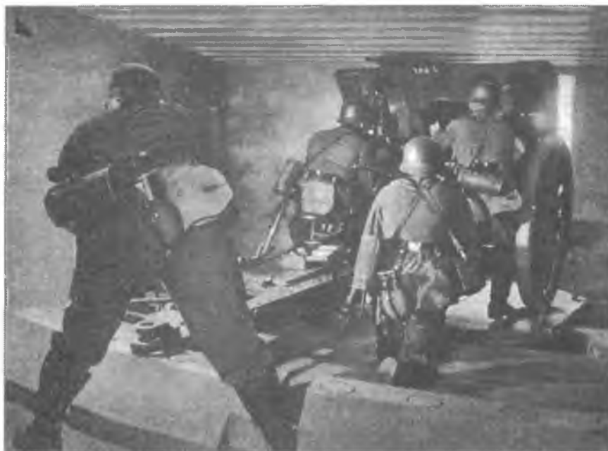
Орудийный отсек укреплений Западного вала.
