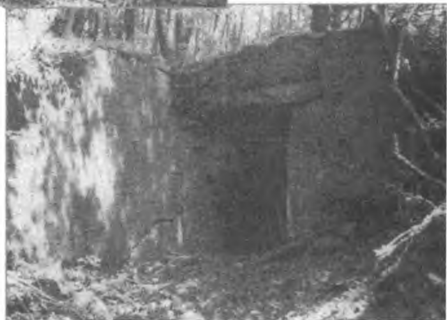
Стандартная строительная конструкция 11 на Западном валу в Штольберге под Аахеном. Первоначально проектировалась как командный пункт, но использовалась как вход.
