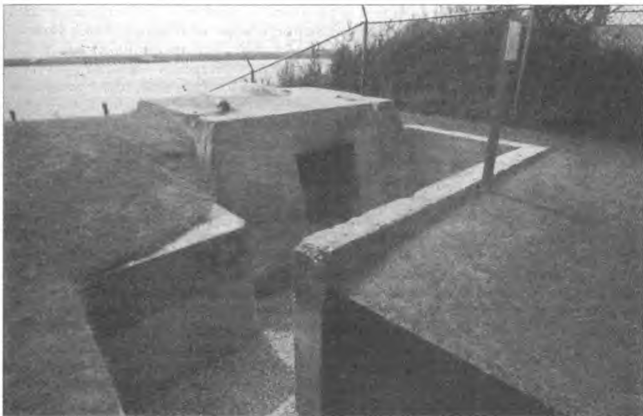
Часть немецкого опорного пункта в месте входа в небольшой порт на острове Валхерен. Немцы добавили бетонированные траншеи, которые видны позади бункера, а сам бункер – голландский, с неподвижной бронированной башней (она на другой стороне), которая в 1940 году была установлена на фронтальной части.
