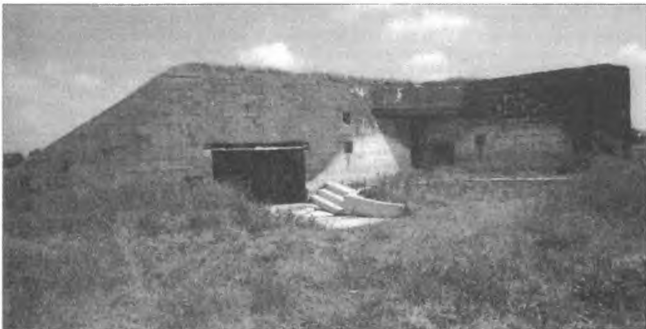
Остров Валхерен. Позиция для 75-мм противотанкового орудия, тип 625. Вид с тыльной части бункера, где имеется вход на орудийную огневую позицию и вход в бункер, защищенный фланговой амбразурой.
