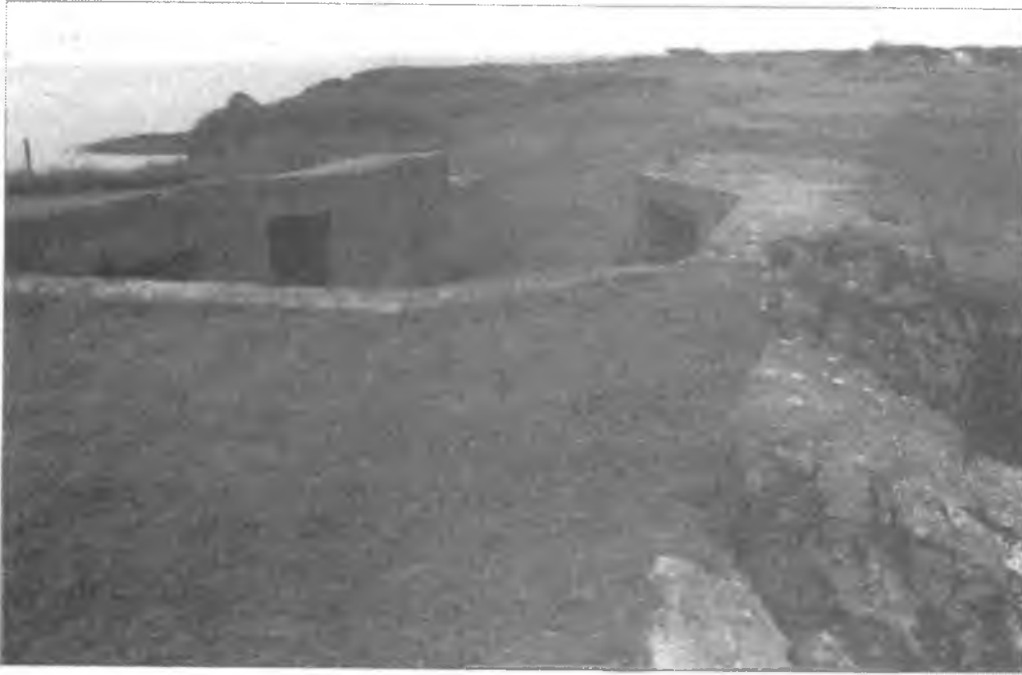
Стандартная строительная конструкция L409a (L – маркировка люфтваффе) для 37-мм зенитного орудия. На фотографии позиция, располагающаяся поверх бункера, на которой, по всей вероятности, устанавливалась 20-мм зенитка.
