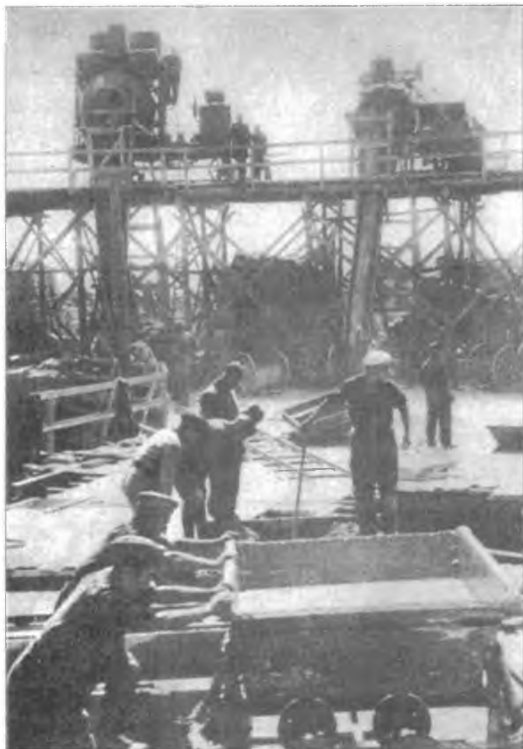
Осень 1940 года. Заливка фундамента каземата на батарее «Тодт».
