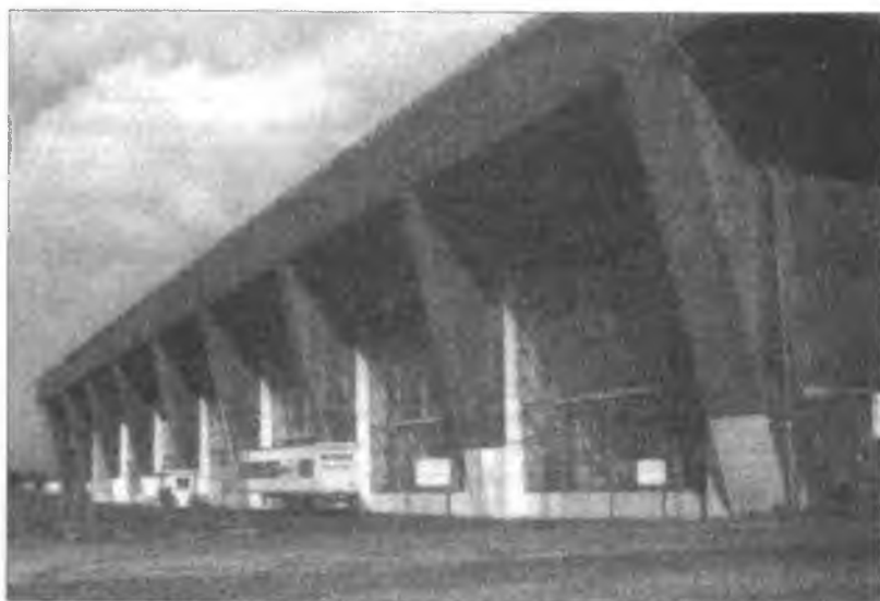
Доки для подводных лодок в Лорьяне. Крупный план бункера Кероман II с защитными дверями, которые сейчас отсутствуют.
