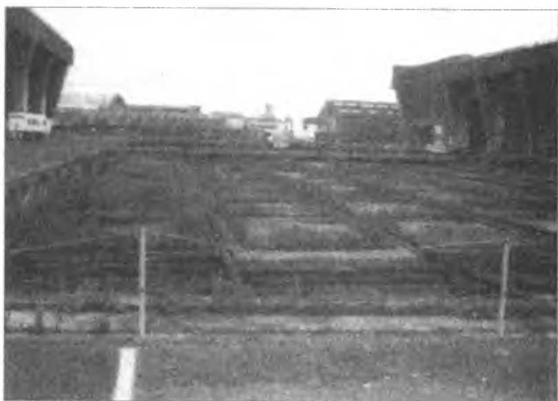
Доки субмарин в Лорьяне. Слева Кероман I, справа – Кероман II. Подводные лодки поднимались из воды с правой стороны бункера Кероман I и переносились на траверзу, которая перемещала их в один из доков этих двух бункеров.
