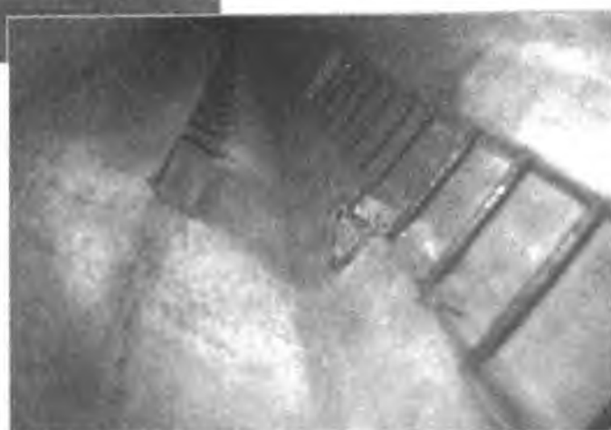
Внутренняя часть форта линии «Ингрид»: видна простота внутреннего устройства. Здесь нет лифтов, и только с помощью лестницы можно добраться в боевые отсеки.
