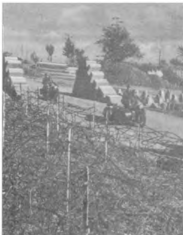
Дорога, идущая через линию «драконовых зубов». С каждой стороны дороги видна бетонированная структура, оснащенная стальными элементами для ограждения дороги.
