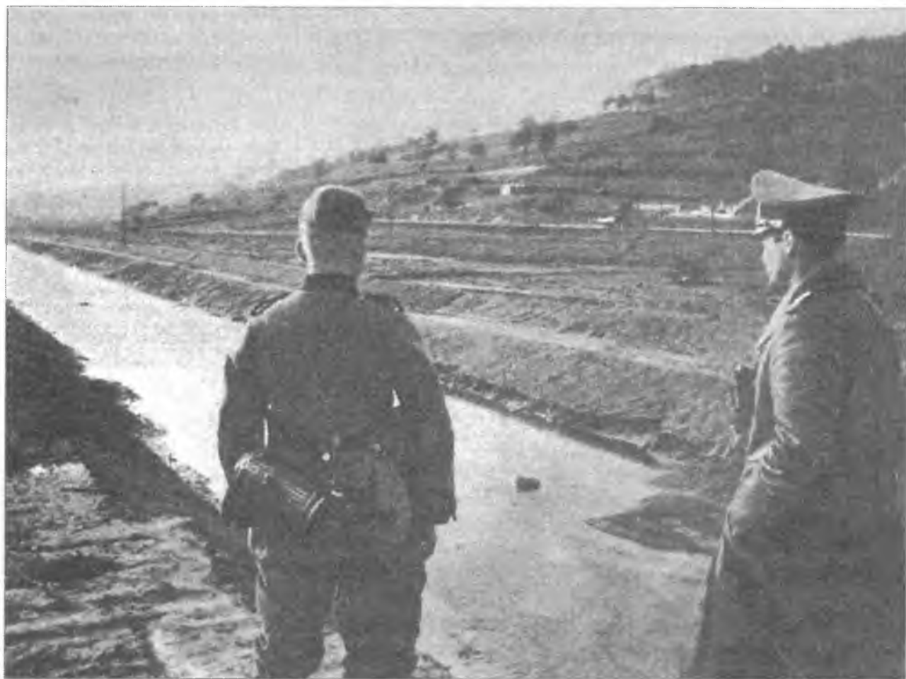
Западный вал, 1938 год. Строительство противотанкового рва.
