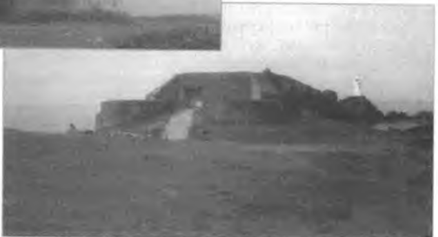
Стандартная строительная конструкция 606 Unterstellraum (укрытие) для 60-см прожектора и осветительного оборудования в Ла-Корбьер, в Джерси.
