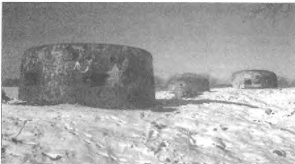
В-Werke (Panzerwerke) 717, укрепленного узла «Шарнхорст» на ОВВ. Слева направо: 6-амбразурный колпак типа 20P7; бронированное вентиляционное отверстие, обозначаемая как Lüftungskuppeln (воздушный купол); отдушина типа 450P01; колпак наблюдения типа 438P01; другие 6-амбразурные колпаки для пулеметов. Фото Роберта Юрга.
