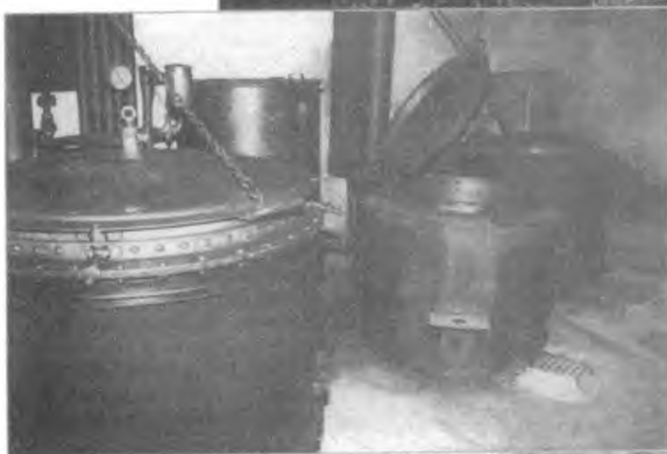
Кухня укрытия J-16.
