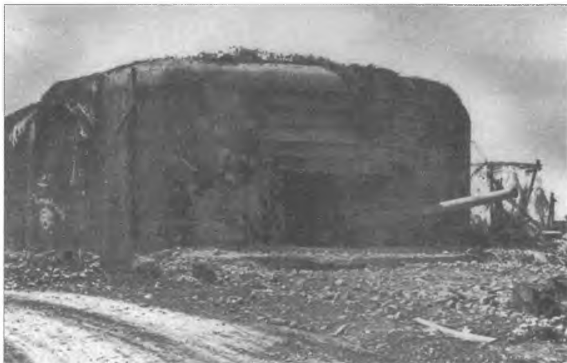
Батарея «Сен-Маркуф» (Крисбек) типовой конструкции 683. В этом каземате размещалось 210-мм чешское орудие. На фотографии – орудие на позиции после захвата союзниками.
