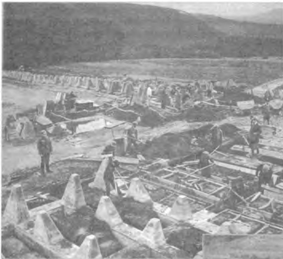
Западный вал, 1938 год. Конструкция «драконовы зубы». Видно, как готовят формы для бетонного основания. На заднем плане (в центре слева) видны формы для «зубов». Внизу на фотографии – законченная линия «драконовых зубов».
