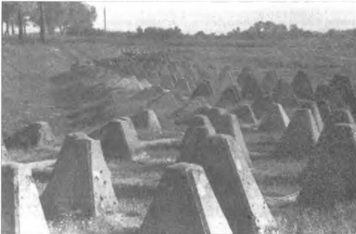
Бетонные «драконовы зубы», построенные до войны на линии ОВВ перед противотанковым рвом. Такие конструкции широко использовались немцами для создания преград движению танков.
