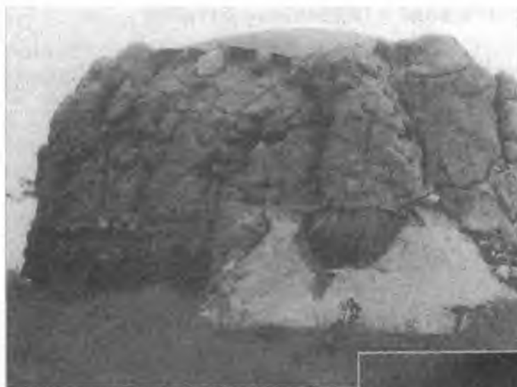
Линия «Ингрид». Тяжелый орудийный блок (тип 1500) форта, расположенного на горе, выходящей на Фиуме. Обратите внимание на купол, встроенный в бетон справа от амбразуры, а также на образец горной маскировки.
