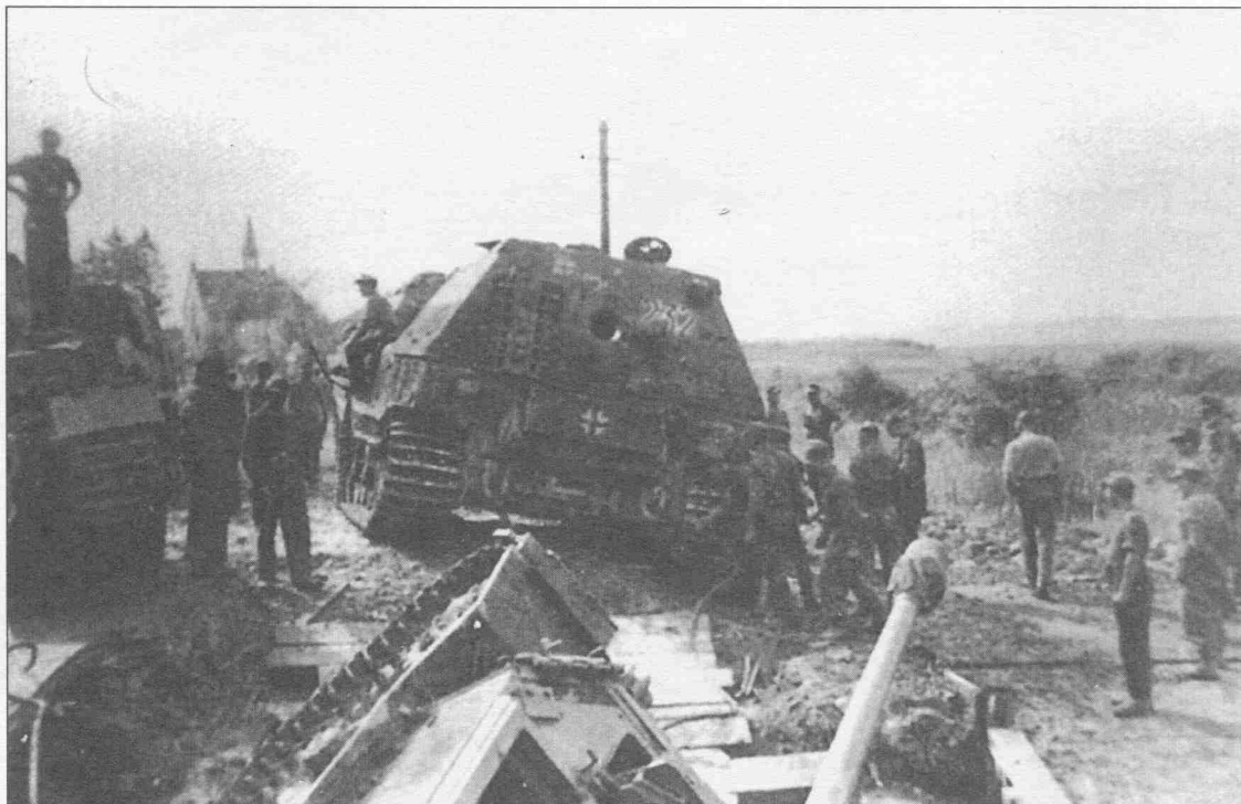
Подготовка к эвакуации провалившегося под мост «Фердинанда». Галиция 1944 г. The recovery of Ferdinand after the bridge disintegrated under the vehicle.
