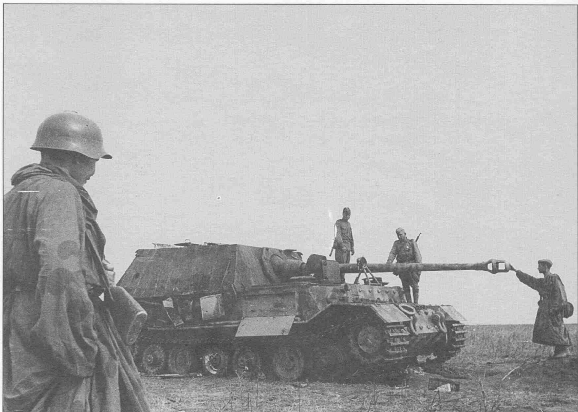
Разведчики 13-й армии рассматривают подбитый «Фердинанд». Машина имеет пробоину в левом борту у тормозного барабана. 17-20 июля 1943 г. Scout unit of 13th Army inspects destroyed Ferdinand. Note the artillery shell hole near the brake case.
