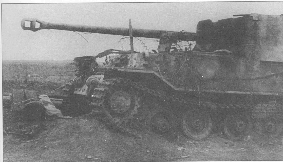
Самодельная сетка над моторным отделением «Фердинанда» укреплена для защиты от бутылок КС. Поньри 15 июля 1943 г. Custom-made net above the Ferdinand's engine compartment protected
