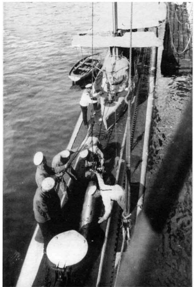
На подводную лодку “Карась” идет погрузка торпеды Севастополь, 1910 е гг.
